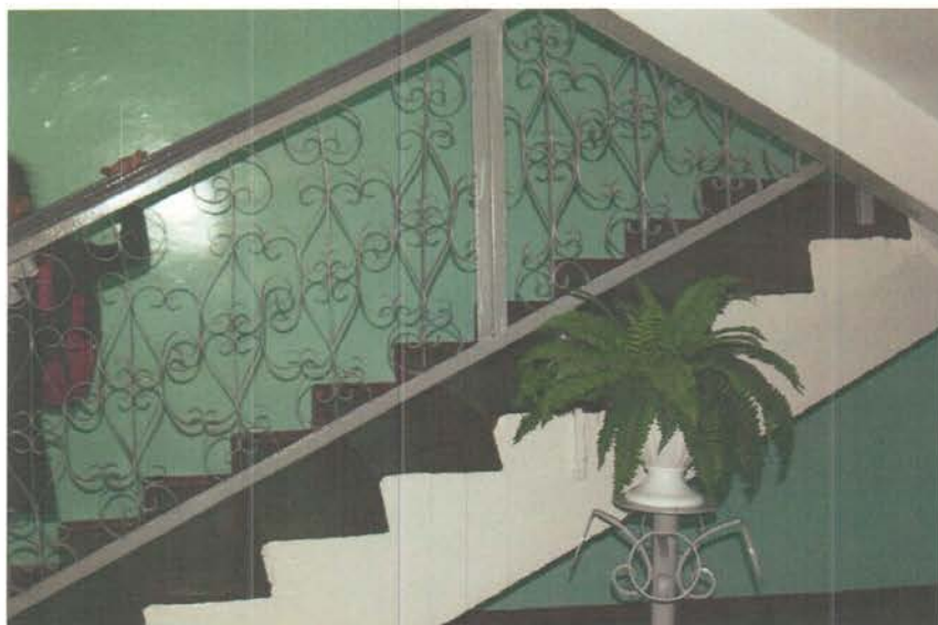
Фото № 14,15 Лестница (внутри здания)
